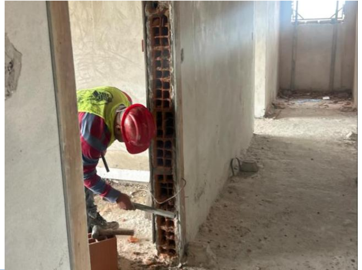
Trabajos de revoque exterior y mochetas de puertas en Torre 20
