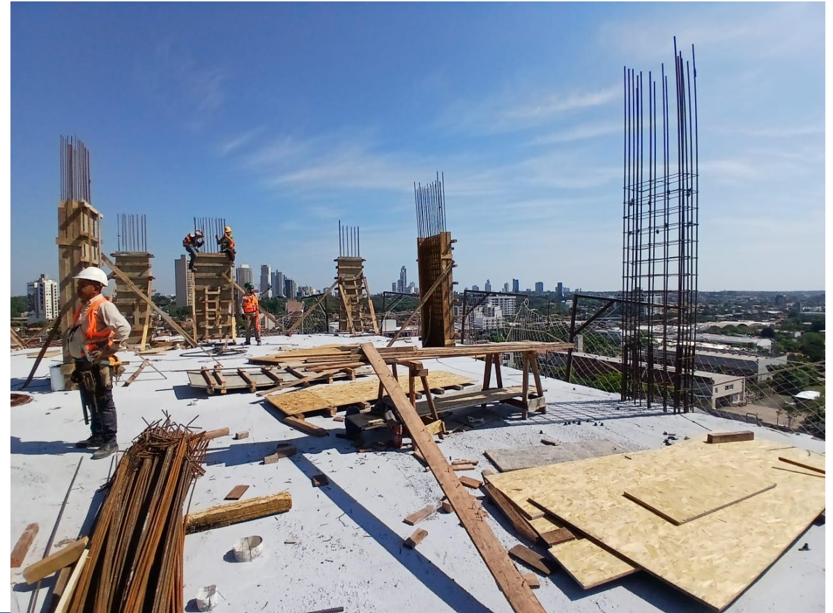
Cargamento de pilares en Torre 20
