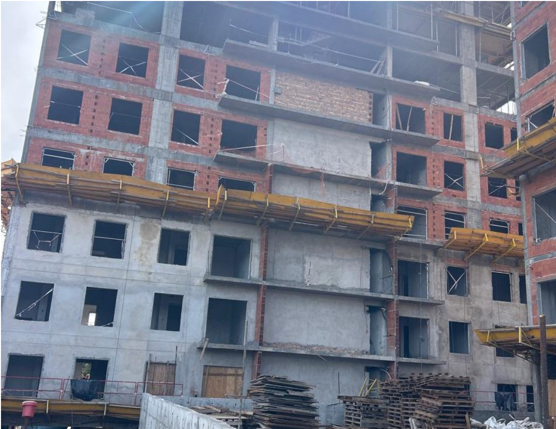
Trabajos de revoque exterior y mochetas de puertas en Torre 20
